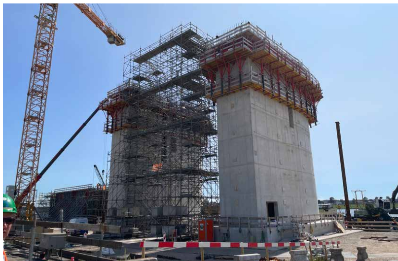
Figuur 3 De pijlers en wanden (links) en de combiwanden (rechts) in aanbouw
