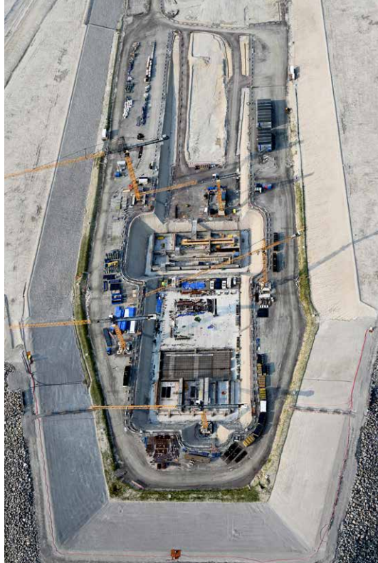
Figuur 3: Bouwput in-situtunnel op Lolland, juli 2023 (Bron: Femern AS)
