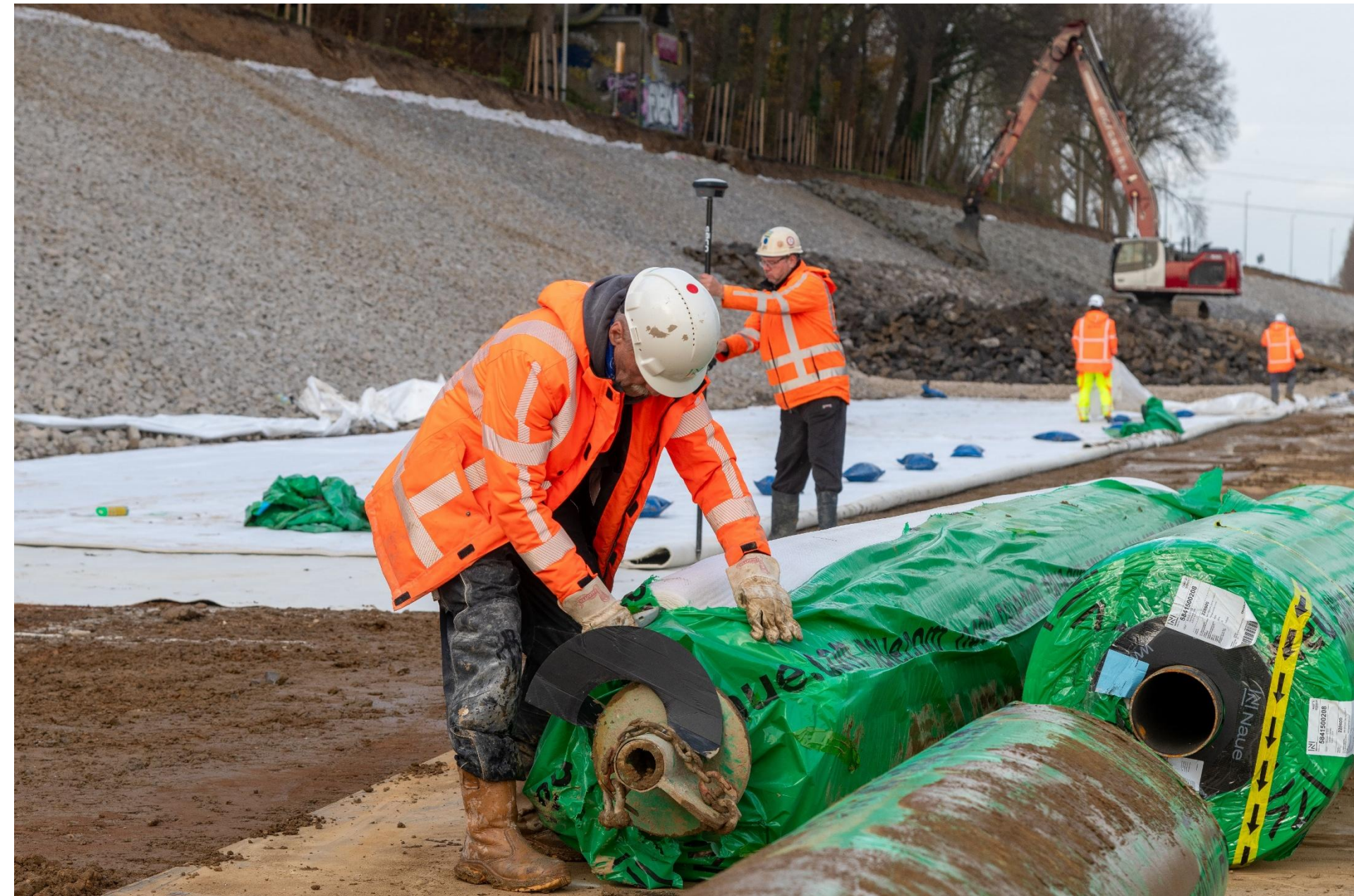
Bentonietmatten i.p.v. Geocomposiet
